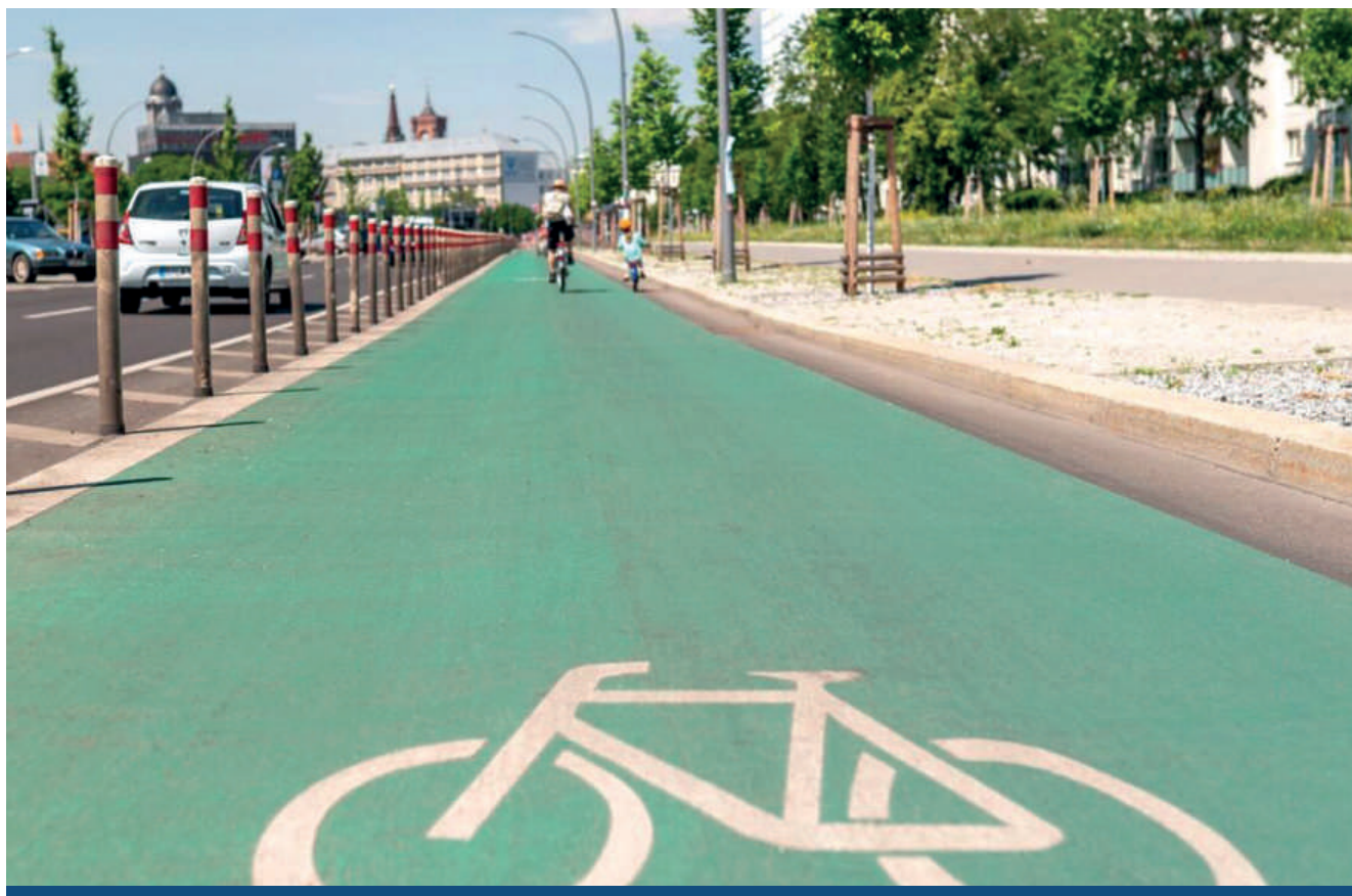
Geschützter Radfahrstreifen in Berlin, Holzmarktstraße © april agentur GbR
